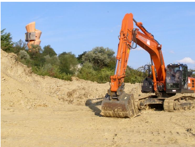
Beginn der Arbeiten, im Hintergrund das Wahrzeichen der Fossilien-Welt
